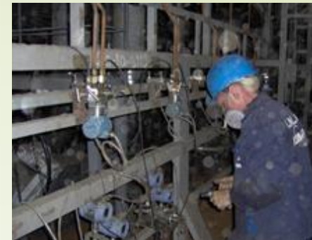
Masurare debit injectie abur intermediar si apa alimentare intrare cazan
